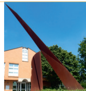
Bisinger Straße 35, Polizeigebäude
