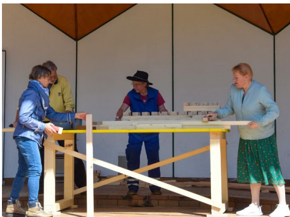
17 Bau der letzten drei Holzlagen (Foto: Gunar Seitz, 2025)
