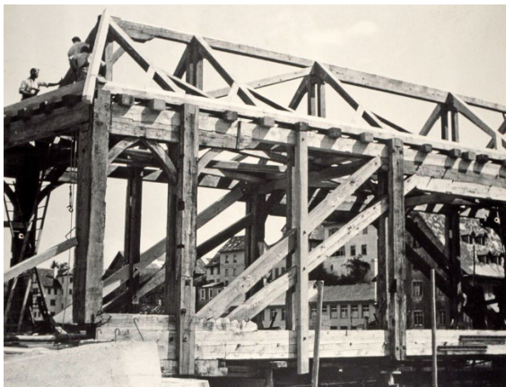
6 Wiederaufbau durch die Fa. Albert Ott (Quelle: Datum und Autor unbekannt, Digital-Fotoarchiv der Gemeinde Gailingen)
