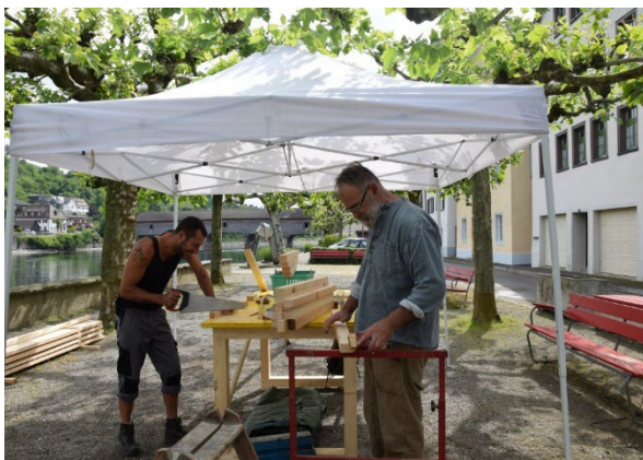
20 Zuschneiden der Dachlatten (Foto: Gunar Seitz, 2025)
