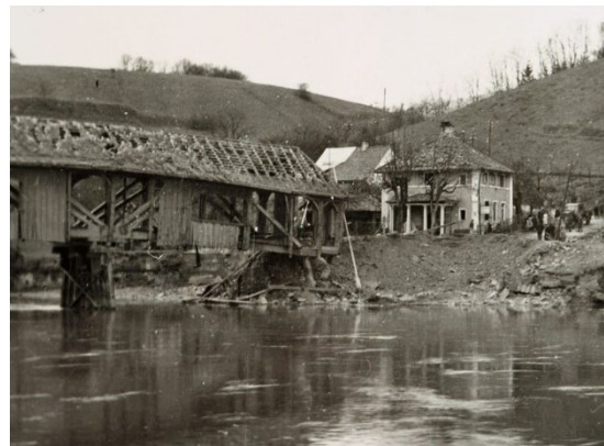
5 Beschädigte Brücke und Gailinger Ufer (Quelle: Heinrich Waldvogel, s. o.)
