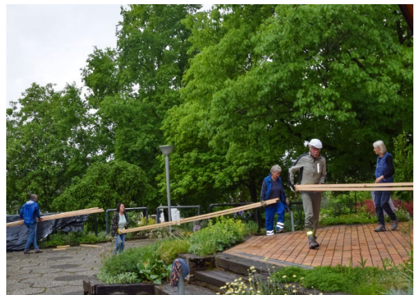
16 Vorbereitung der Baustelle (Foto: Gunar Seitz, 2025)
