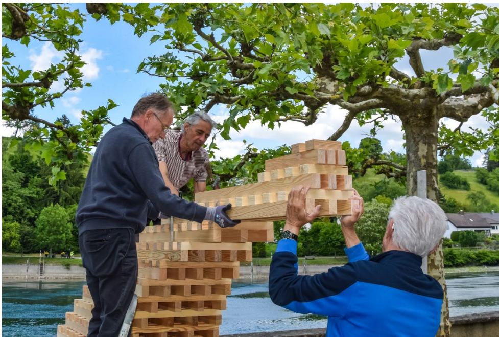
19 Schlussarbeiten am Bauplatz Diessenhofen (Foto: Gunar Seitz, 2025)
