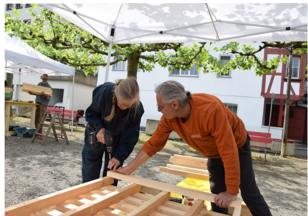
21 Montieren der Latten (Foto: Gunar Seitz, 2025)
