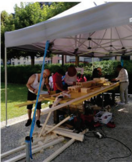
Aufbau einer Brücke bei einem Projekt in Luzern 2022
