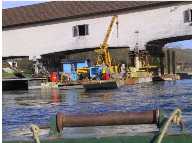
42 Die Sanierung der Rheinbrücke von 2002 (Quelle: Digital-Fotoarchiv der Gemeinde Gailingen, Datum und Autor unbekannt)
