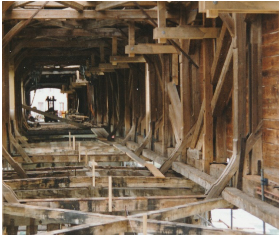
41 Die Sanierung der Rheinbrücke von 1996 (Quelle: Digital-Fotoarchiv der Gemeinde Gailingen, Datum und Autor unbekannt)
