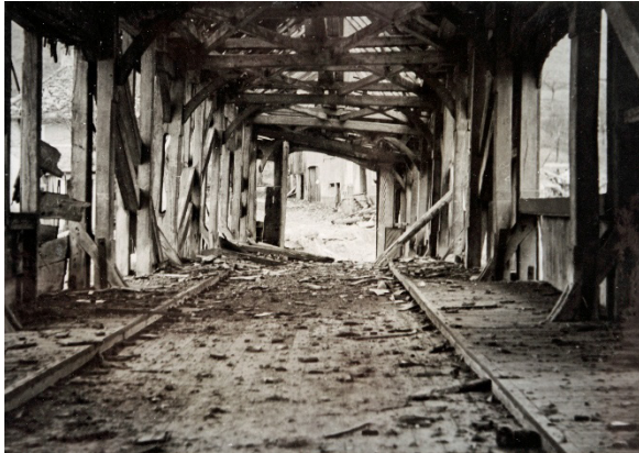
29 Innenaufnahme der durch die Detonation teilzerstörten Brücke. (Quelle: Heinrich Waldvogel: Kleine Chronik des Zweiten Weltkriegs von Diessenhofen aus gesehen, Archiv Stadtgemeinde Diessenhofen, Digitalisat)
